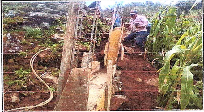
Foto 2: SUSTITUCION DE MURO PERIMETRAL
