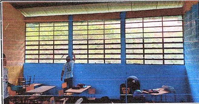
Foto 6: SUSTITUCION DE PINTURA DE AULAS
