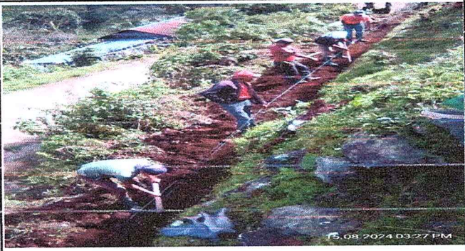
Foto1: SUSTITUCION DE MURO PERIMETRAL
