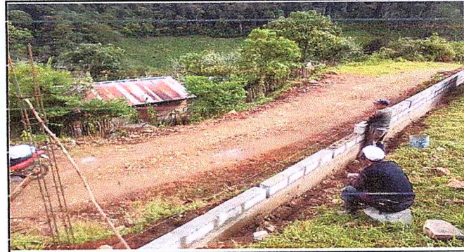
Foto 4: SUSTITUCION DE MURO PERIMETRAL
